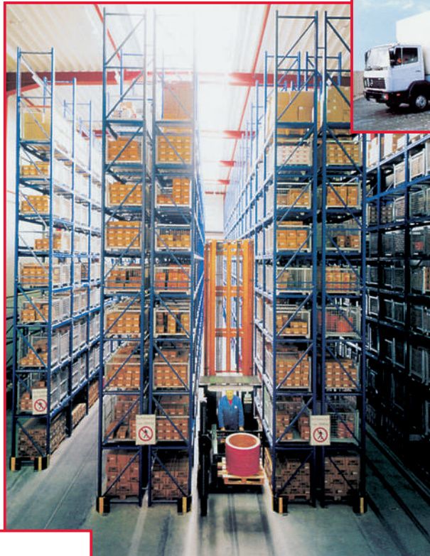
Das Mitte 1996 errichtete zentral-computergesteuerte Hochregallager
